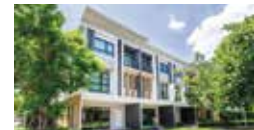
ขนาด 5 kW 1phase : 233 ยูนิต (จำนวนรวมทั้งโครงการ)
