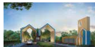
VENUE 24 เวสต์เกต S:UU FTTx : 235 units
